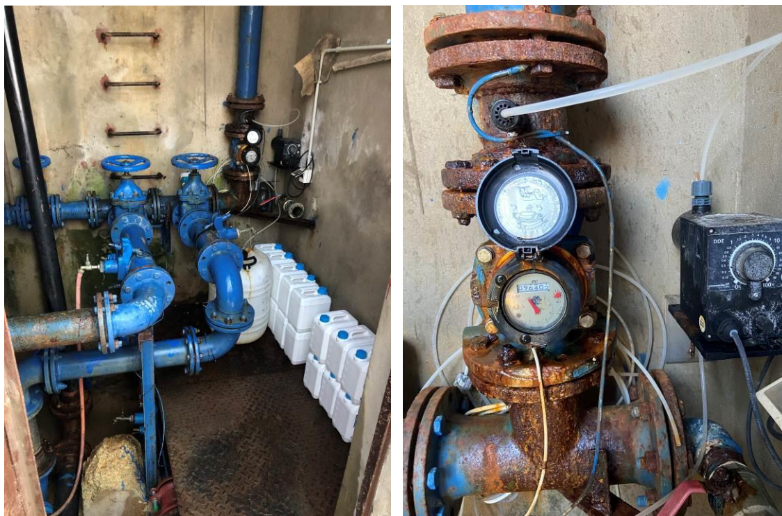
Slika XI-2: Unutrašnjost rezervoara Djevojačke vode
