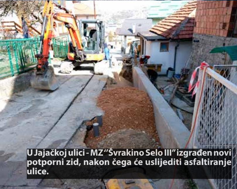
**U Jajačkoj ulici - MZ "Švrakino Selo III" izgrađen novi potporni zid, nakon čega će uslijediti asfaltiranje ulice.**
