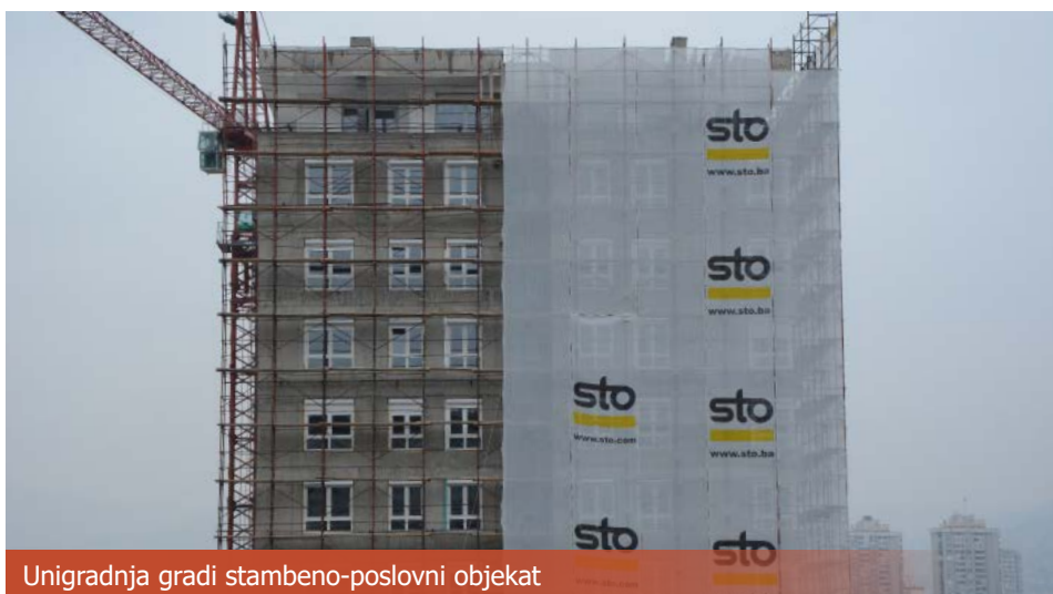
Izgradnja naselja "Nova Otoka"
